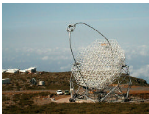
Figura 2: La estructura del telescopio MAGIC antes de montar los espejos y la cámara (Agosto de 2002, fotografía de H.-G. Börsst).
