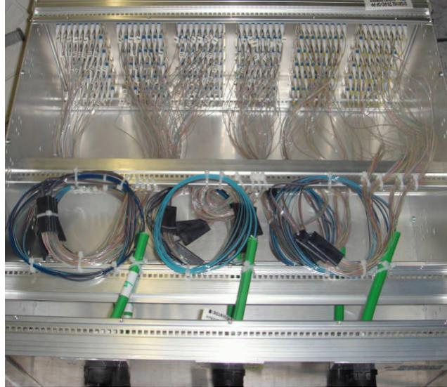
**Figura 6.5:** Imagen del panel de interconexión en USC de las fibras “multi-ribbon” que interconectan las tarjetas ROS y TSC con los sistemas DDU y DTTF respectivamente.
